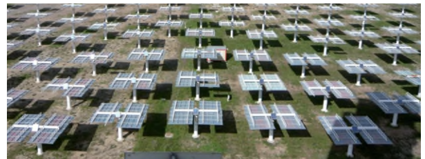
Abb. 1 Drehbare Spiegel der Plataforma Solar de Almería lenken das Sonnenlicht auf einen zentralen Solarreceiver an der Spitze eines Turmes. (Foto: DLR)
