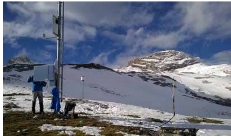
Abb. 3: Installation eines Temperaturfühlers zur Messung der Schneedeckentemperatur an einer Messstation auf dem Zugspitzplatt im Herbst 2014.
