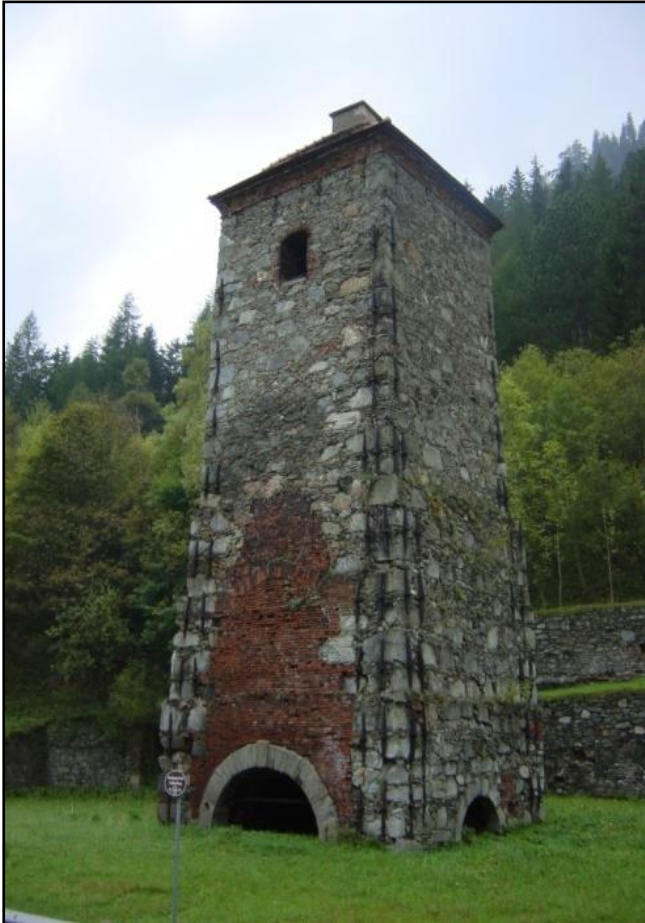
ABB. 28: AUS NATURSTEIN ERBAUTER OFENSTOCK (FOTO DURCH DIE VERFASSER)
